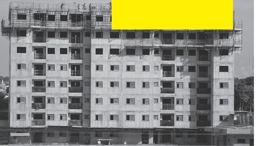
MOLDES DE ALUMINIO PARA MUROS DE CONCRETO
