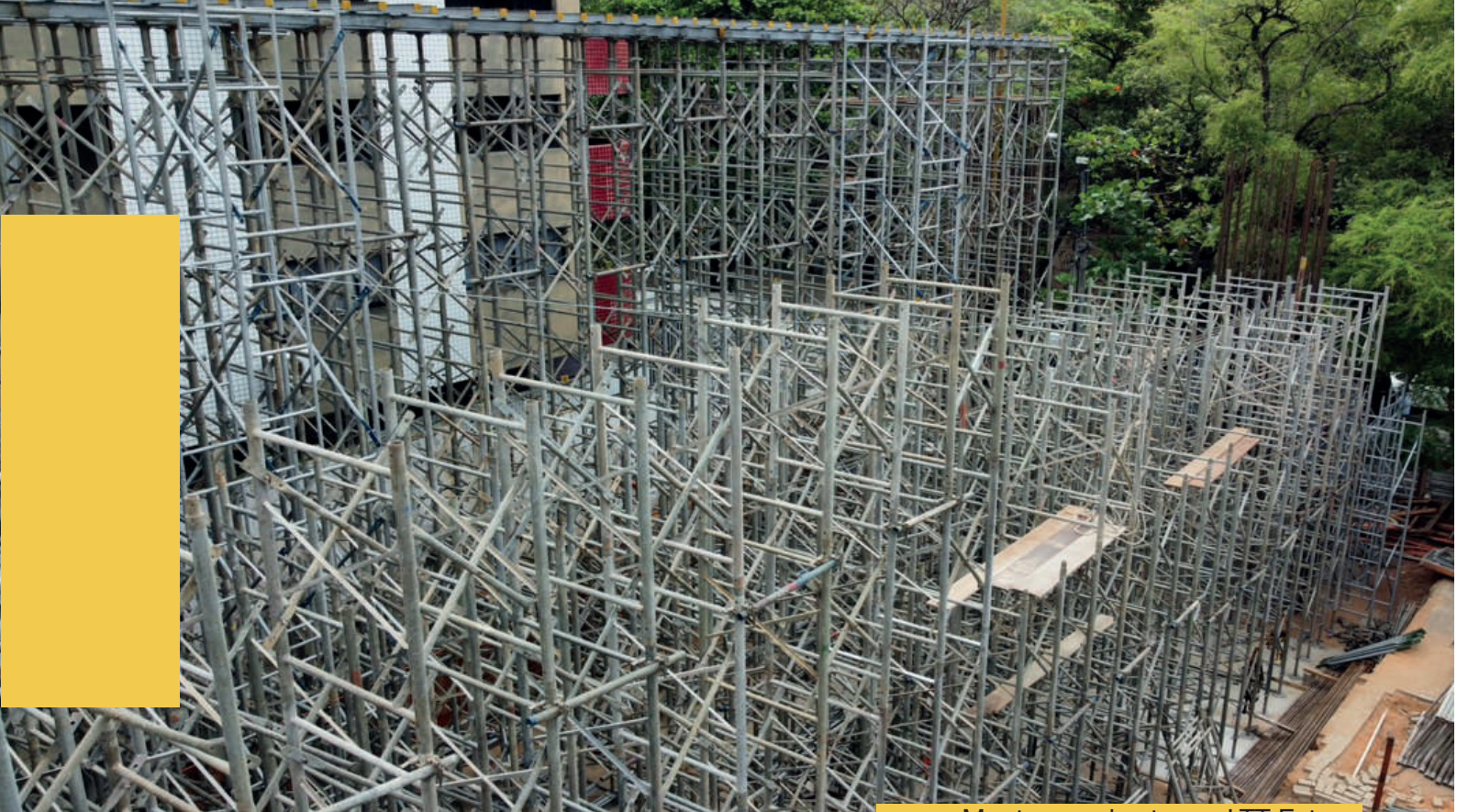
Montagem das torres LTT Extra para o escoramento das vigas
