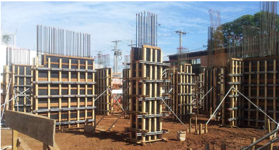
Imagem 204: Obra Passarela Park Prime - Mato Grosso do Sul - gabarito de arranque
