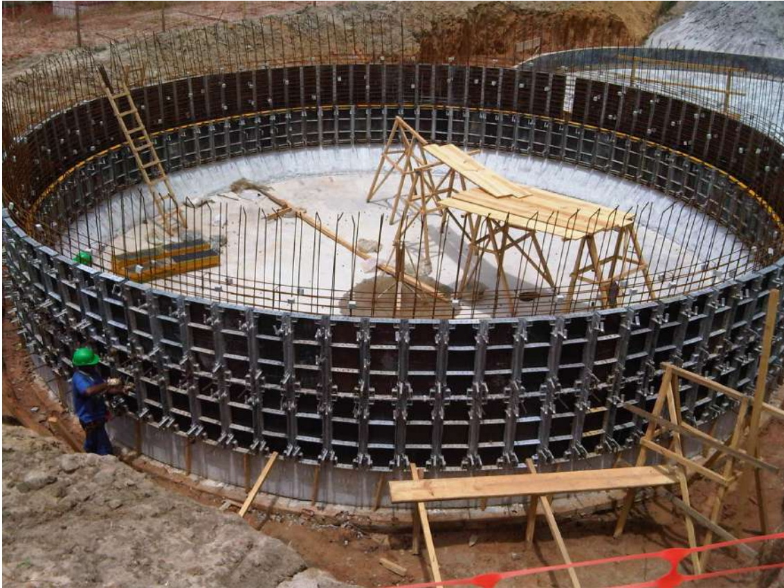
Imagem 281: Obra ETA Aracajú - Sergipe
