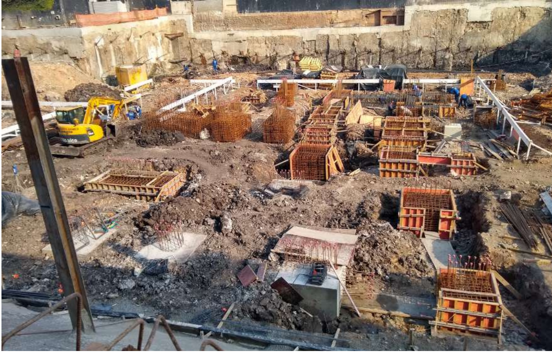
Imagem 124: Obra Thera Ibirapuera - São Paulo - fôrma de madeira para blocos de fundação
