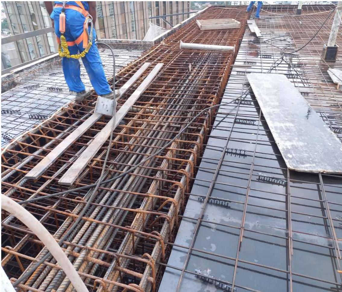
Imagem 112: Obra JK Square - São Paulo
