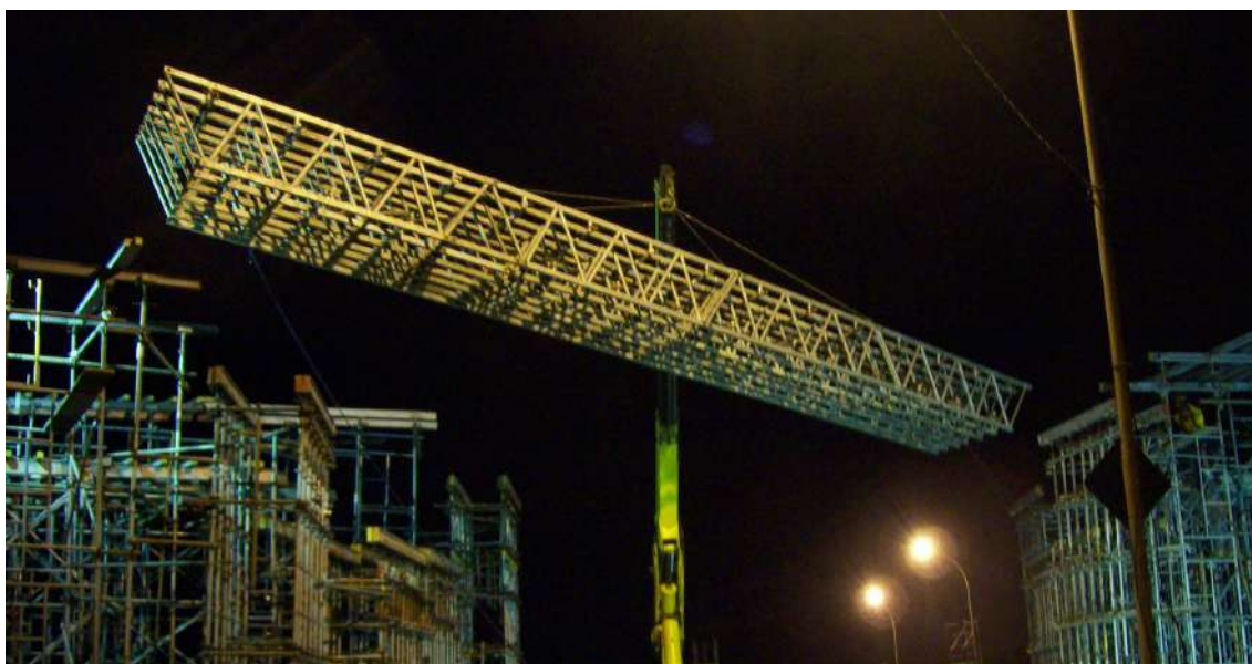
Imagem 315: Obra Sistema Viário Dois de Julho – Bahia
