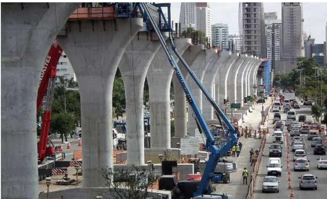
Imagem 162: Pilares concretados, Monotrilho - São Paulo
