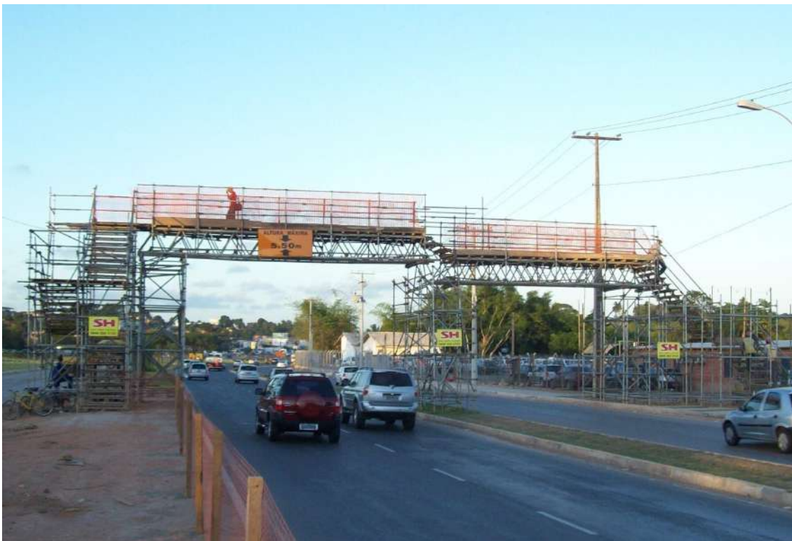
Imagem 314: Obra Sistema Viário Dois de Julho – Bahia
