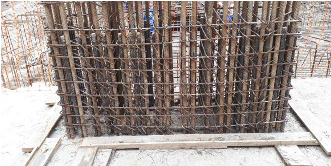
Imagem 203: Obra Edifício Birmann B32 - São Paulo - arranque de gastalhos
