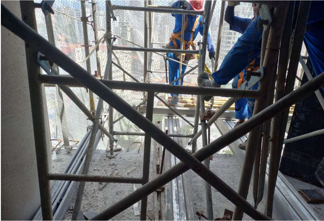
Imagem 73: Obra JK Square - São Paulo
