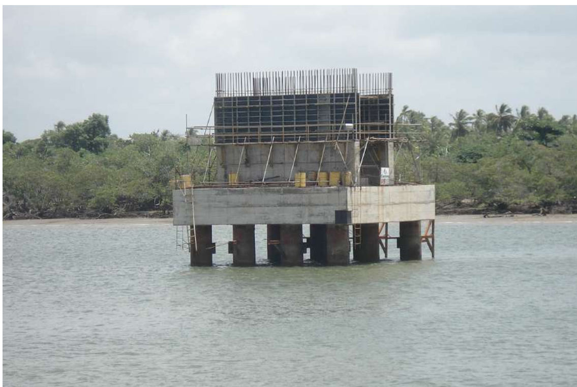
Imagem 297: Obra Ponte sobre o rio Vaza Barris - Sergipe
