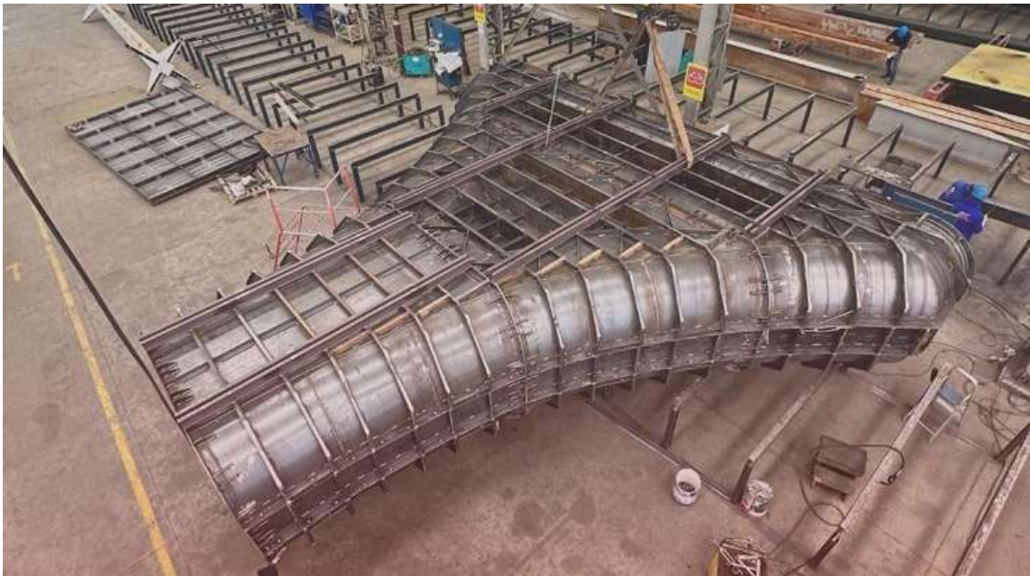
Imagem 161: Fôrmas metálicas especiais para pilares do Monotrilho - São Paulo
