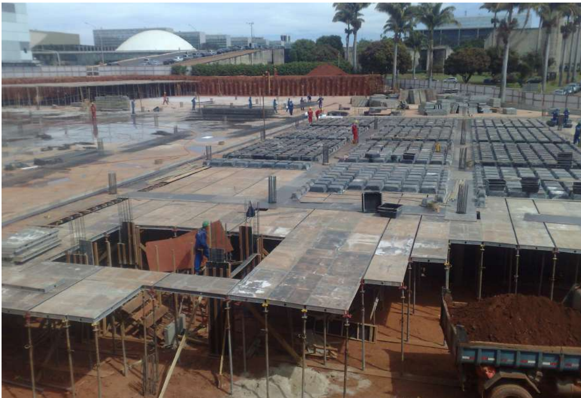
Imagem 63: Obra garagem do Palácio do Planalto - Distrito Federal
