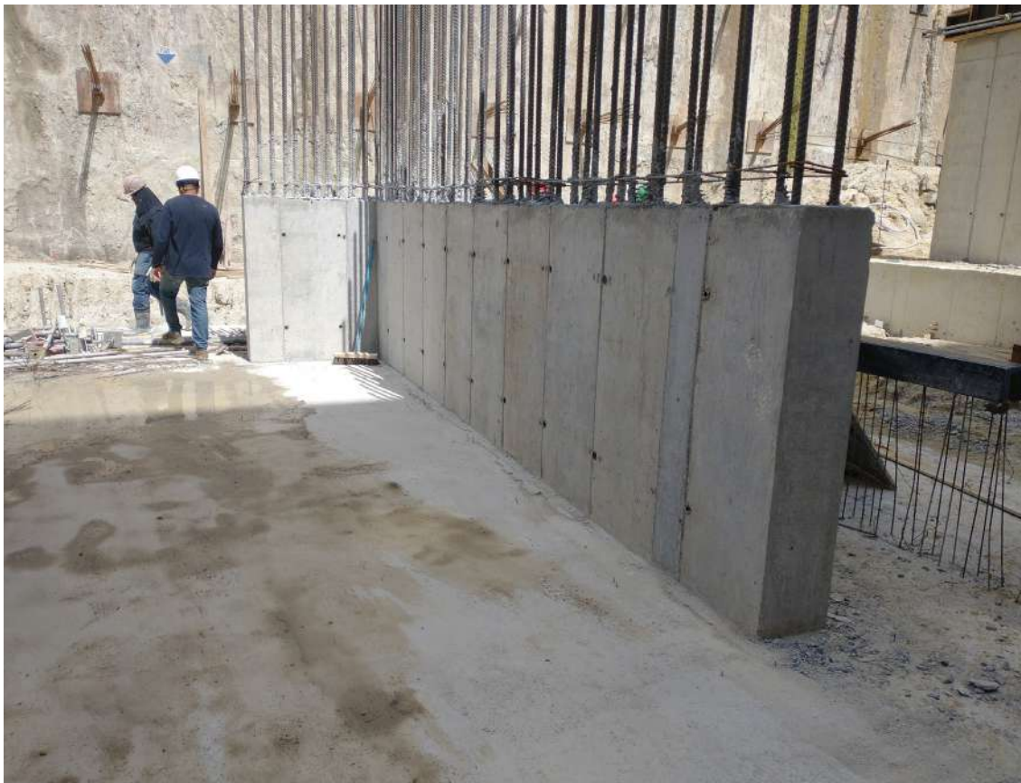
Imagem 190: Obra - JK Square - São Paulo - Pilar desformato Concreform SH®
