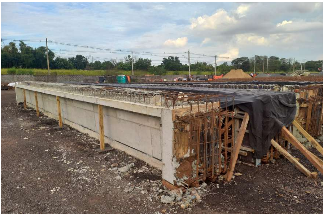
Imagem 115: Obra suplicação SP294 - Rod. Comandante João Ribeiro de Barros - viga pré moldada in loco - São Paulo
