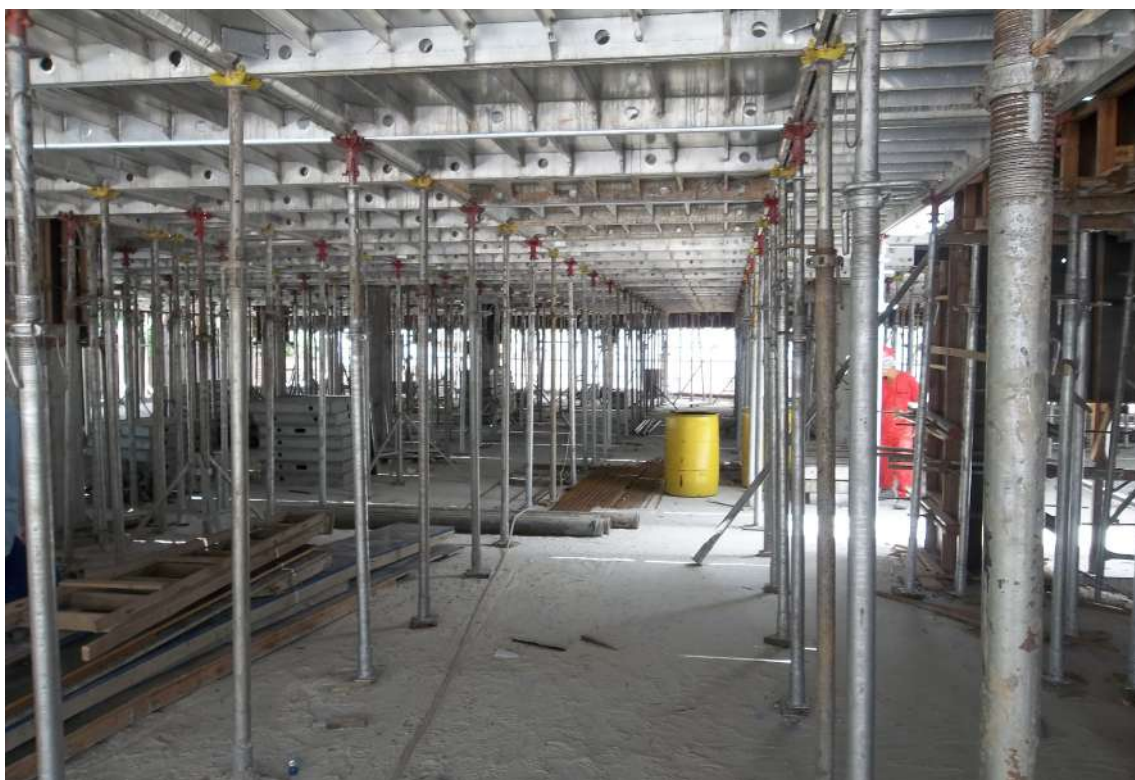
Imagem 29: Obra Civil Port - Bahia
