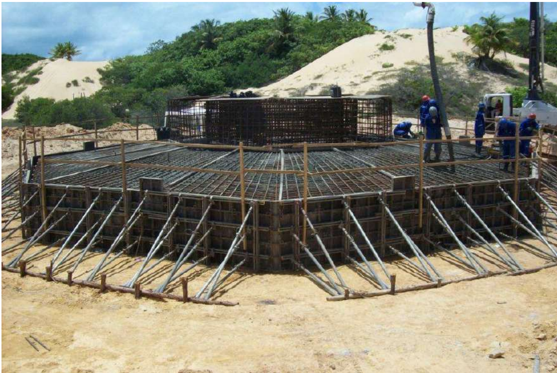
Imagem 286: Obra estação eólica - Sergipe
