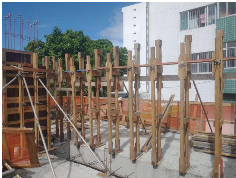
Imagem 91: Obra Edifício The Haus Plaza - Recife
