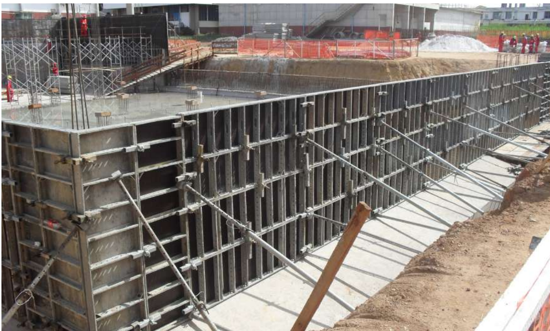
Imagem 144: Obra ampliação do sistema de abastecimento de Macapá - Amapá
