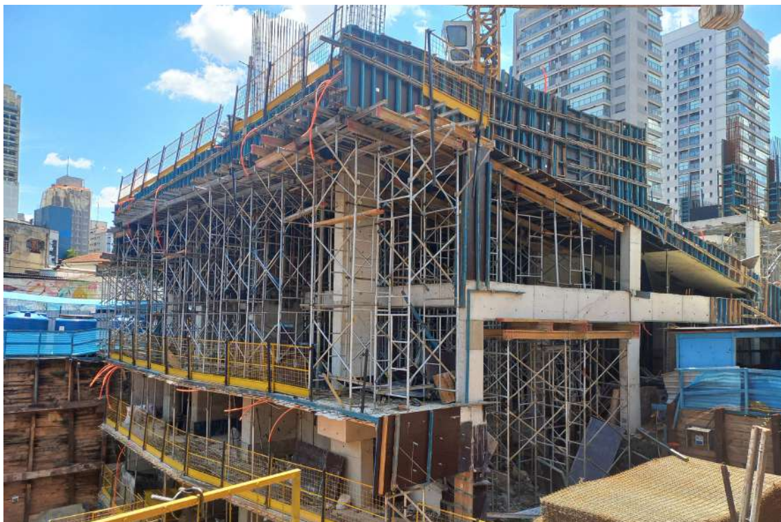
Imagem 69: Obra Residencial Península Vila Madalena - São Paulo
