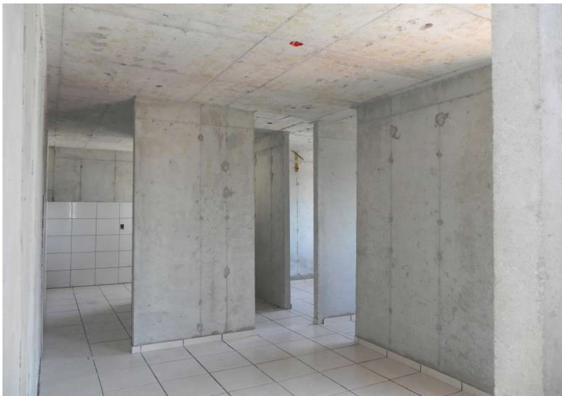
Imagem 294: Obra Bairro Carioca – Rio de Janeiro
