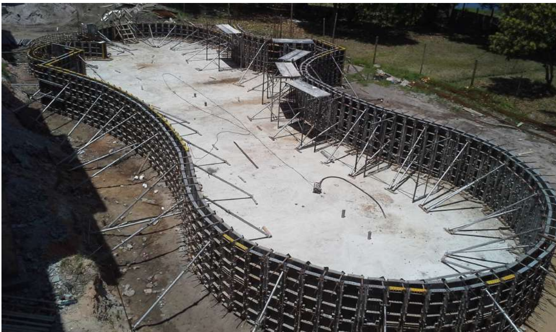
Imagem 134: Obra Apart Paraíso das Águas - Bahia
