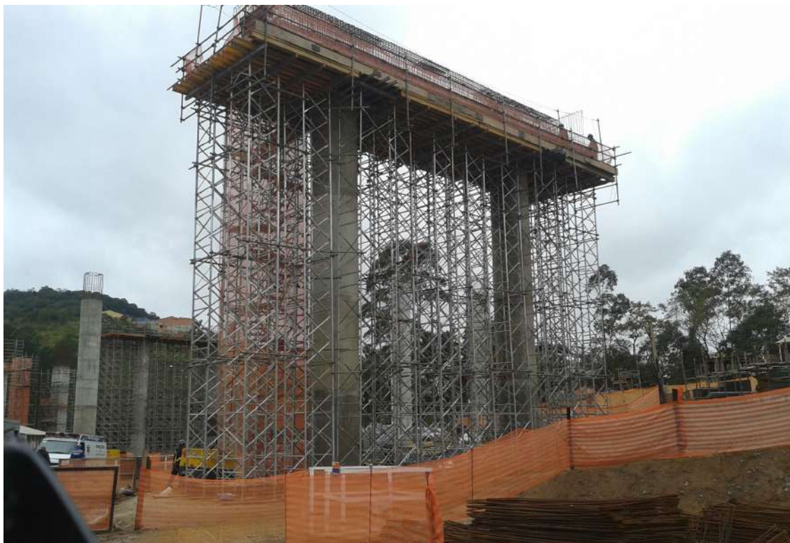
Imagem 54: Obra Rodoanel Norte (lote 5) - São Paulo
