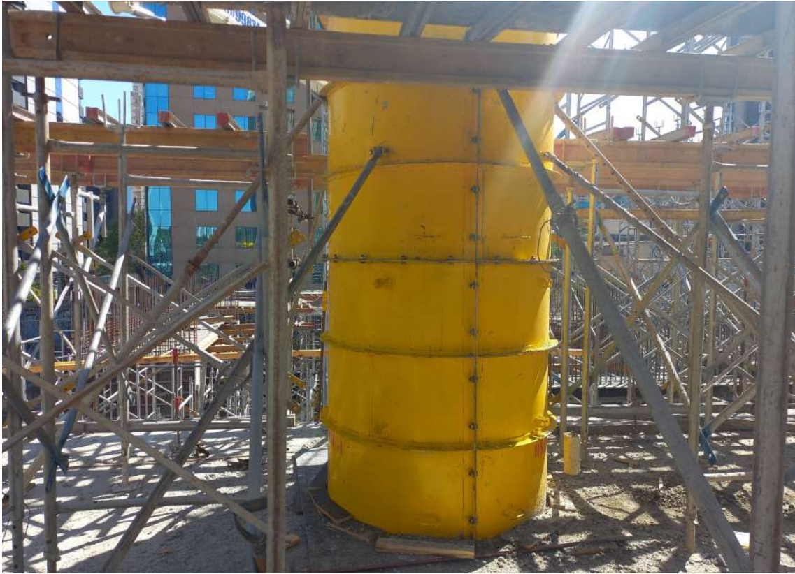
Imagem 201: Obra JK Square – São Paulo – Fôrma Circular SH
