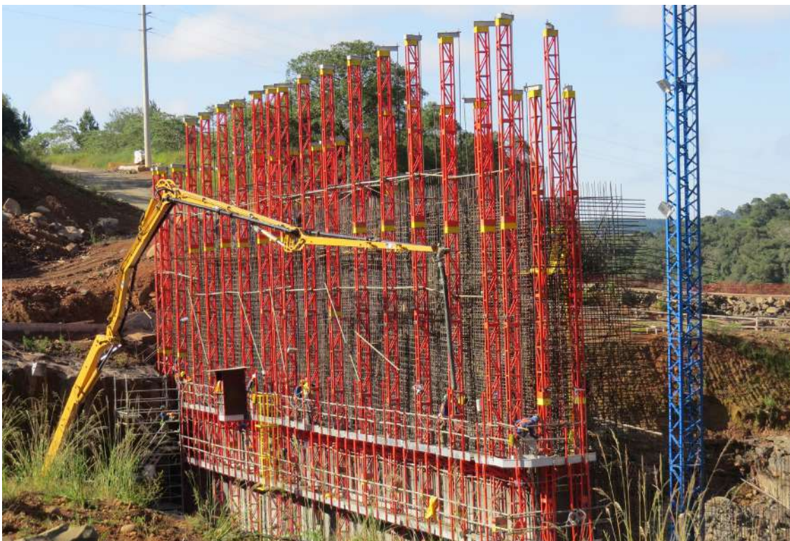
Imagem 168: Obra UHE Salto Curucaca - Curitiba
