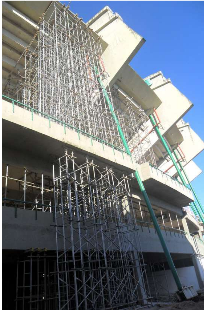
Imagem 120: Obra Castelão para imploração de parte do estádio - Ceará
