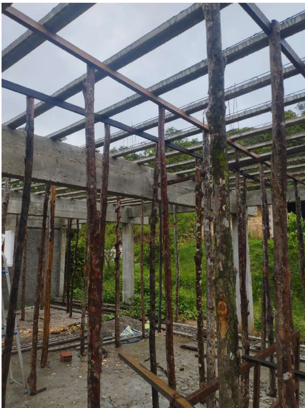
Imagem 92: Obra residência unifamiliar - Recife
