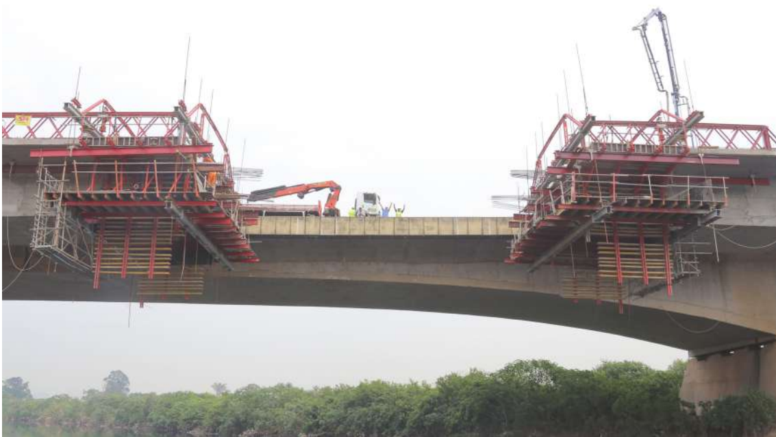
Imagem 310: Obra Ponte sobre o Rio Tietê - São Paulo
