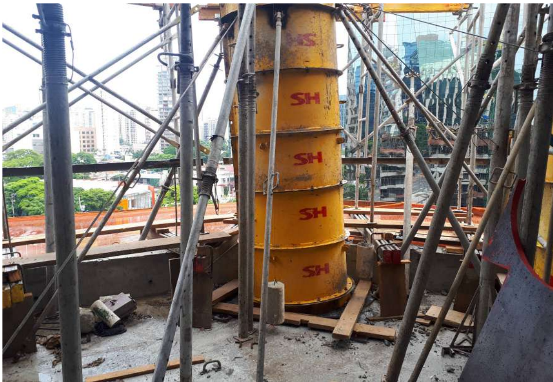
Imagem 205: Obra Edifício Birmann B32 - São Paulo - prumo e escoramento para pilar inclinado
