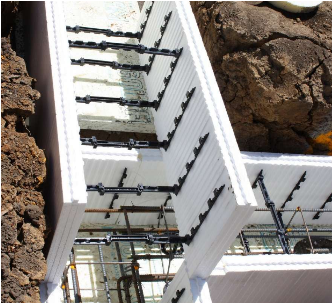
Imagem 169: Fôrma e EPS
