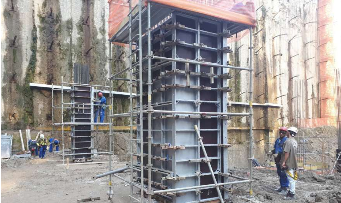
Imagem 143: Obra Edifício Birmann - São Paulo
