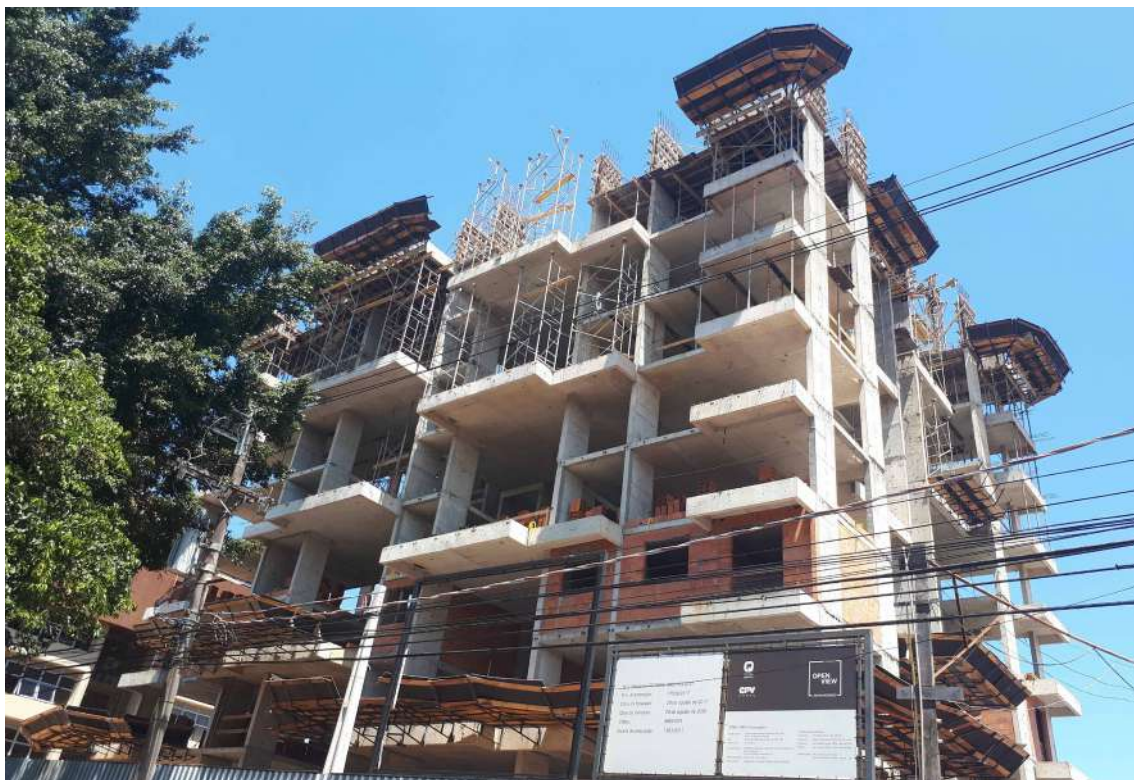
Imagem 60: Obra Open View – Jundiaí SP
