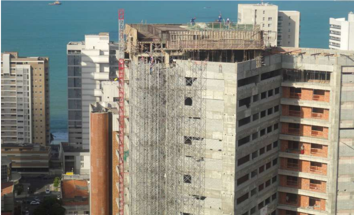
Imagem 55: Obra Green Tower - Ceará
