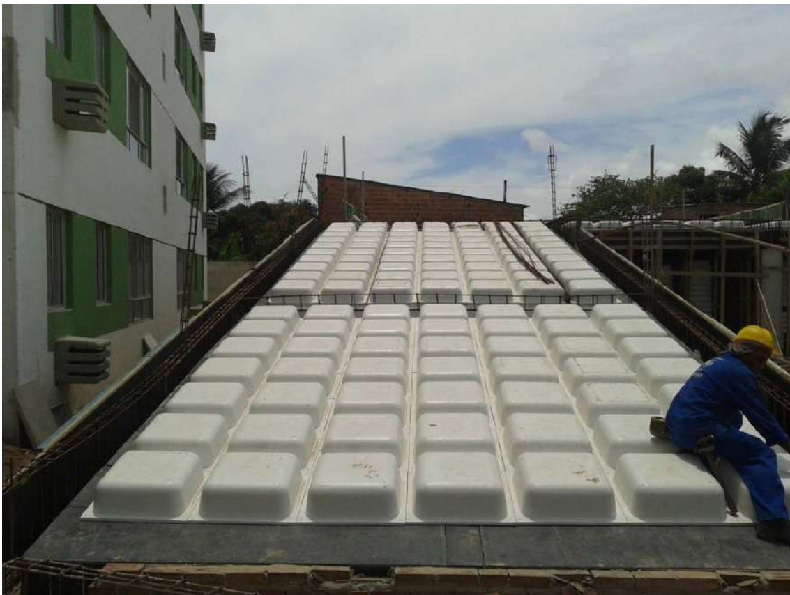
Imagem 72: Obra Saint Enton - Pernambuco
