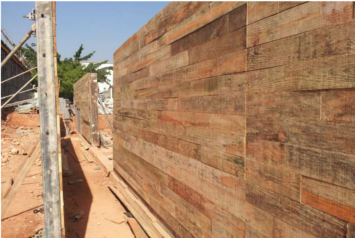
Imagem 127: Obra museu do trabalho e do trabalhador - São Paulo - parede com madeira ripada
