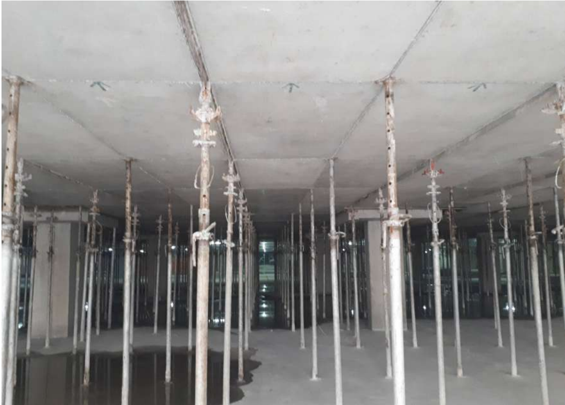
Imagem 34: Obra Edifício Birmann B32 - São Paulo
