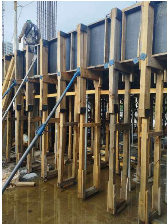
Imagem 90: Obra Edifício Villa Júlia - Recife
