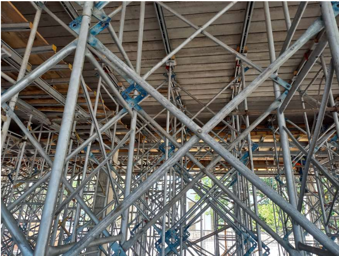
Imagem 66: Obra Umicore Guarulhos, nova sede administrativa - São Paulo
