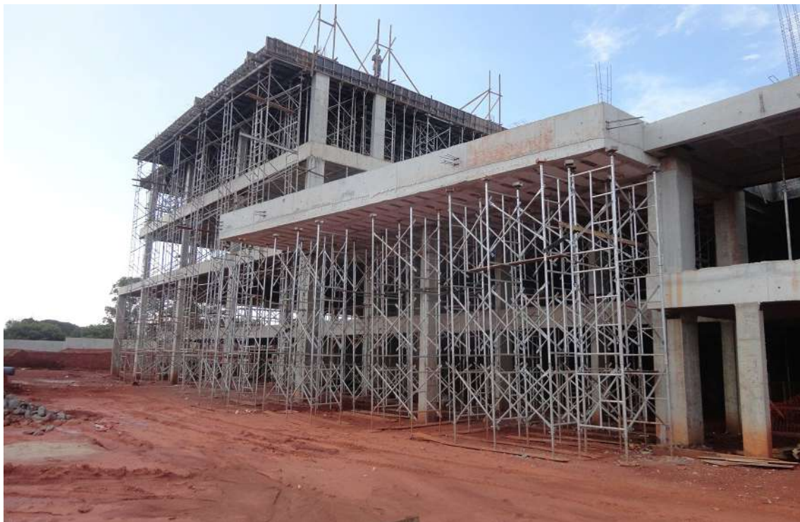
Imagem 23: Obra Tribunal das contas - TCE - Goiás
