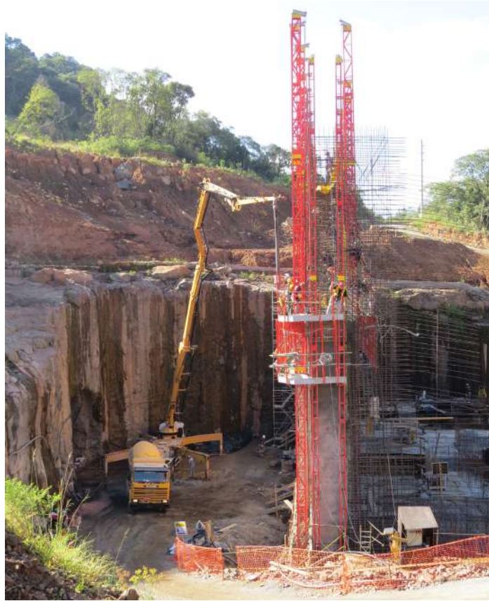
Imagem 167: Obra UHE Salto Curucaca - Curitiba
