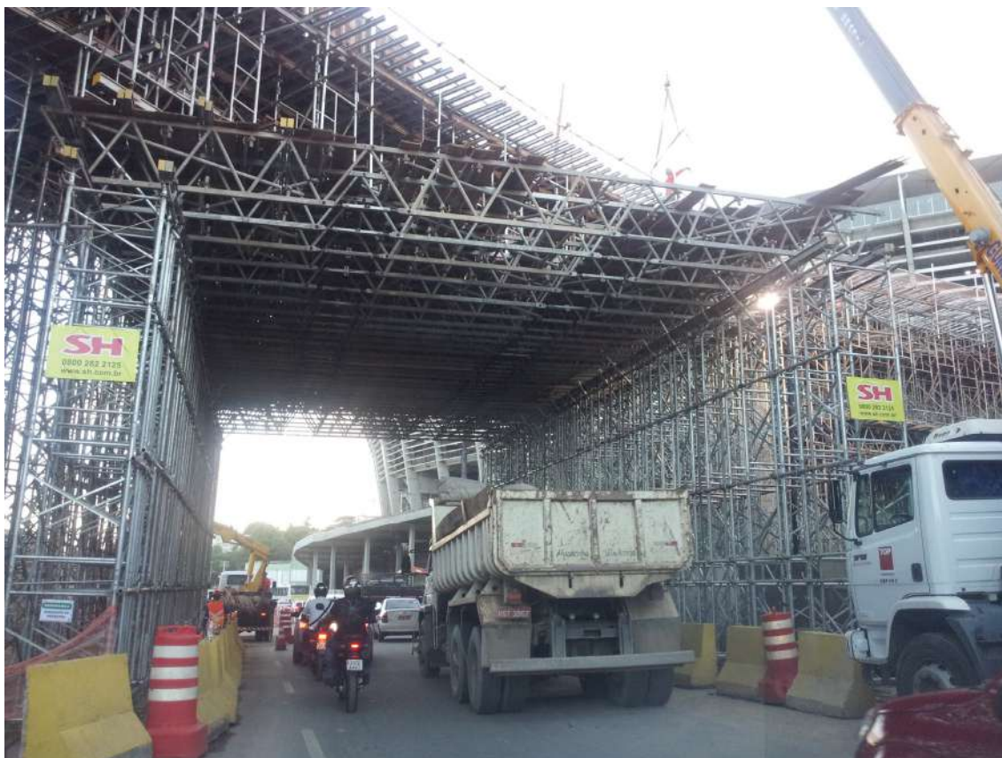
Imagem 298: Obra Acesso ao Fonte Nova - Bahia
