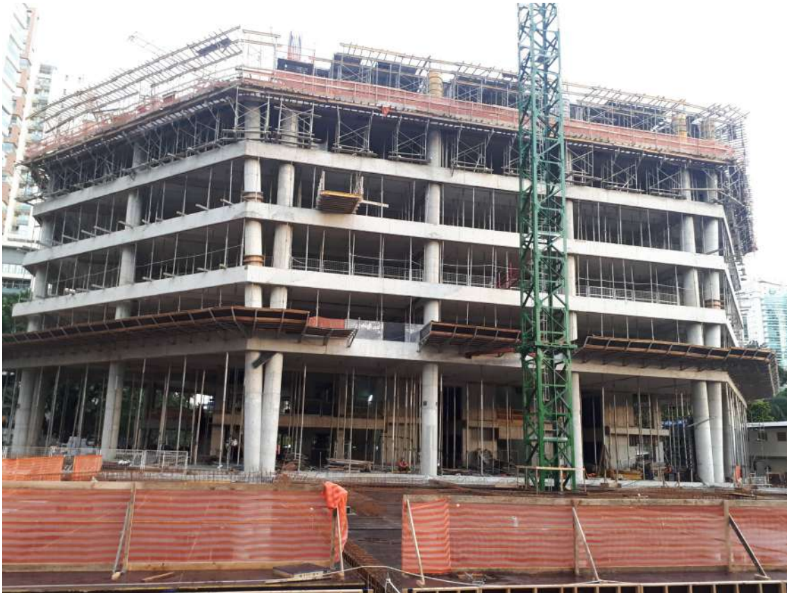
Imagem 210: Obra Faria Lima Plaza – São Paulo
