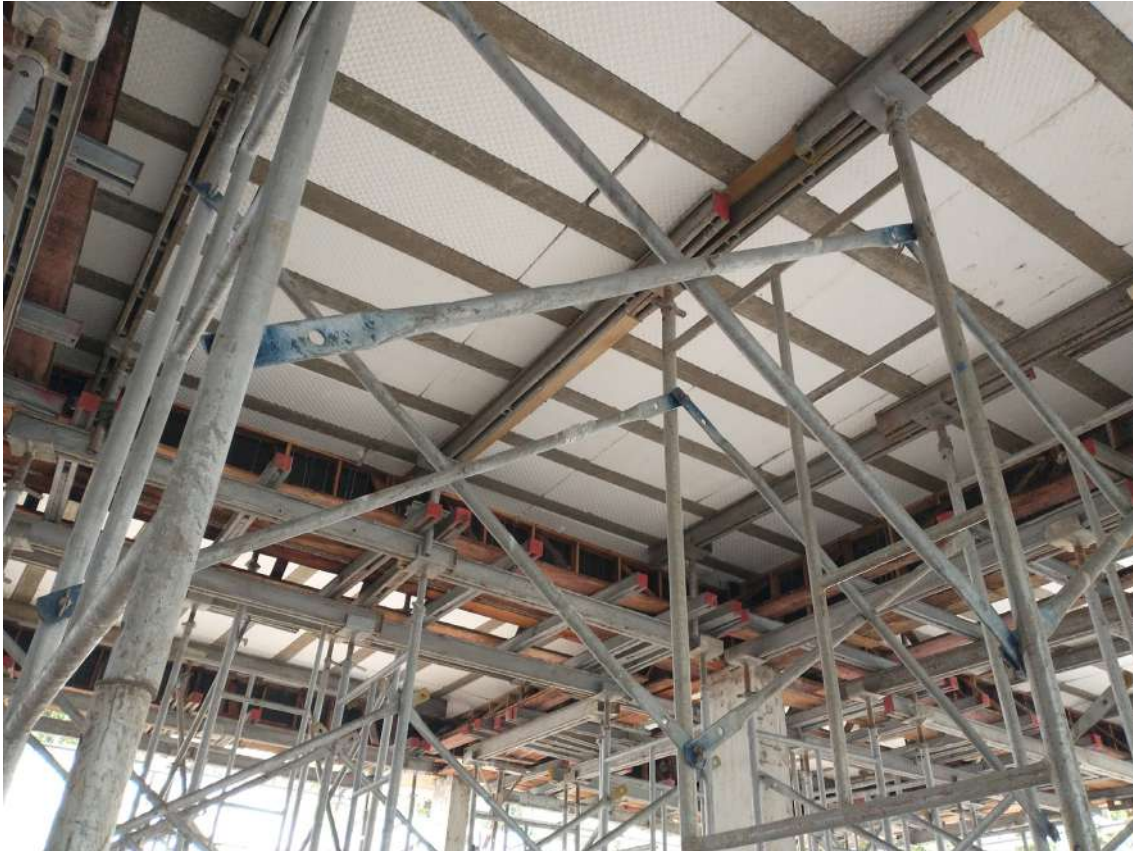
Imagem 67: Obra Mosteiro Arautos Moreno - Recife
