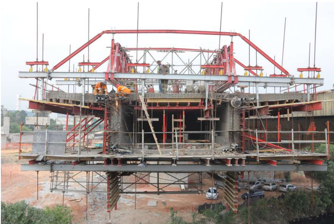
Imagem 309: Obra Ponte sobre o Rio Tietê - São Paulo
