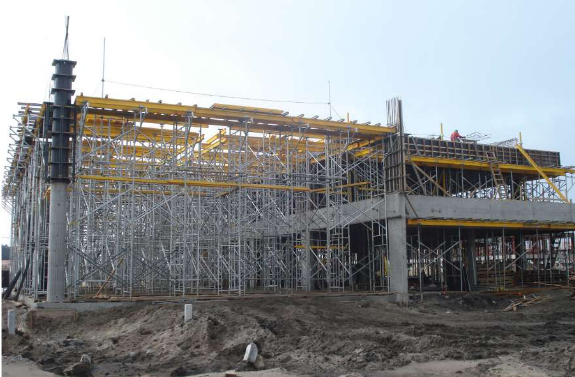
Imagem 164: Obra Residencial Rossi Atlantida – Rio Grande do Sul
