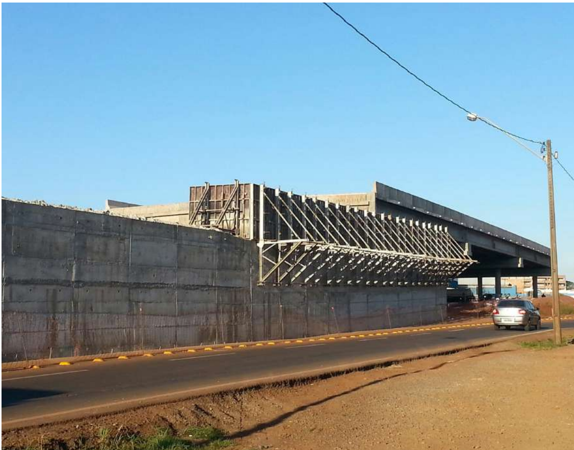
Imagem 173: Obra Av. Dez de Dezembro - Paraná
