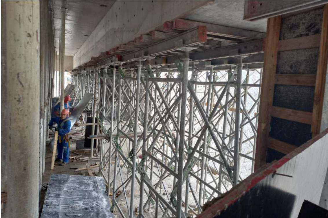
Imagem 113: Obra JK Square - São Paulo
