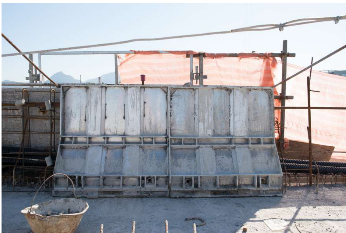
Imagem 312: Obra Ponte Estaiada na Transcarioca – Rio de Janeiro
