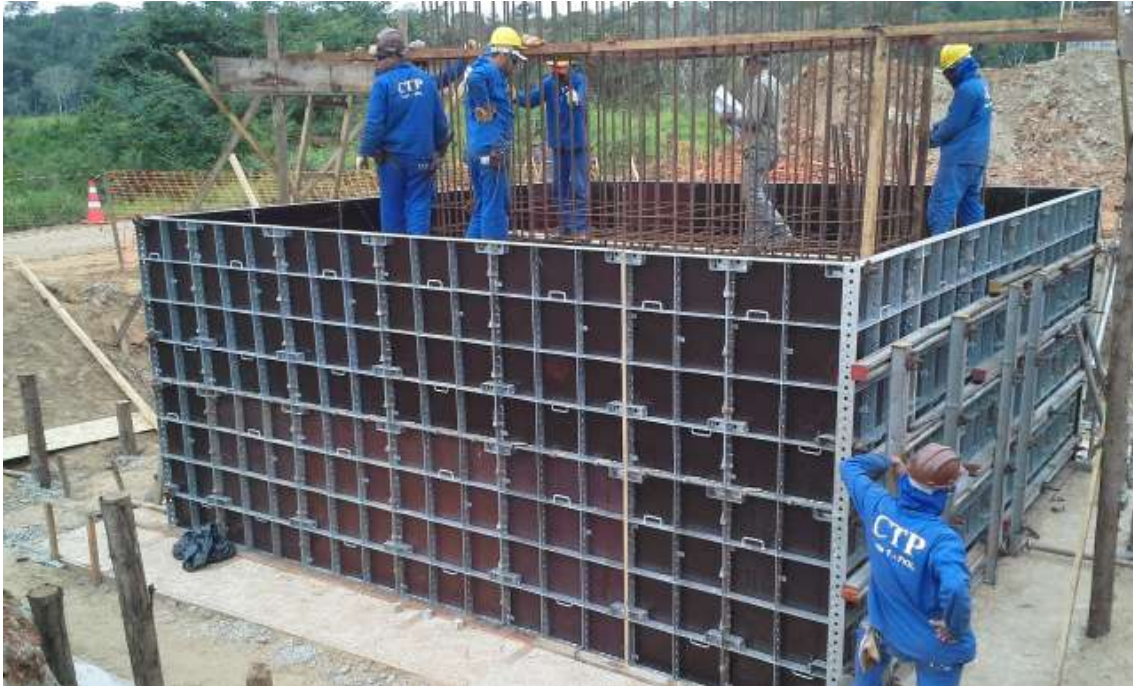
Imagem 133: Obra Ferrovia de Integração Oeste Leste - FIOl (lote 1) - Bahia
