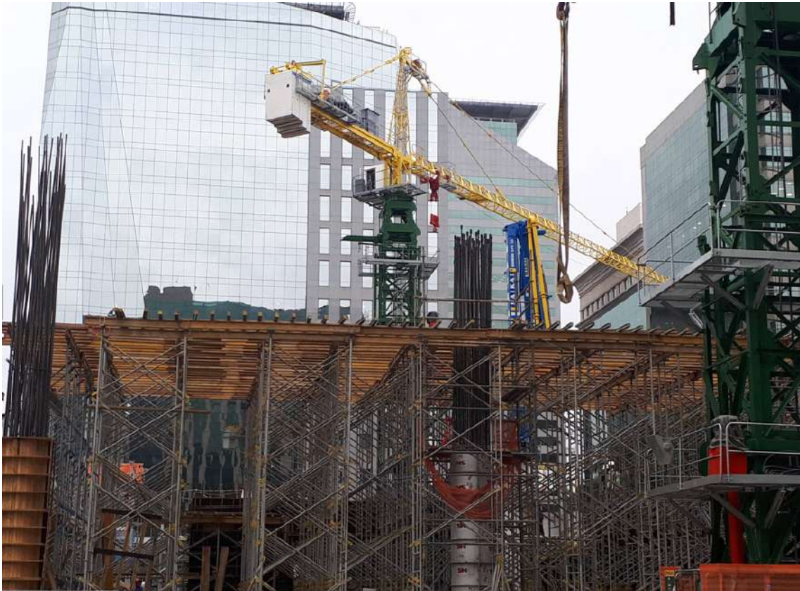
Imagem 20: Obra Edifício Birmann – B32 – São Paulo
