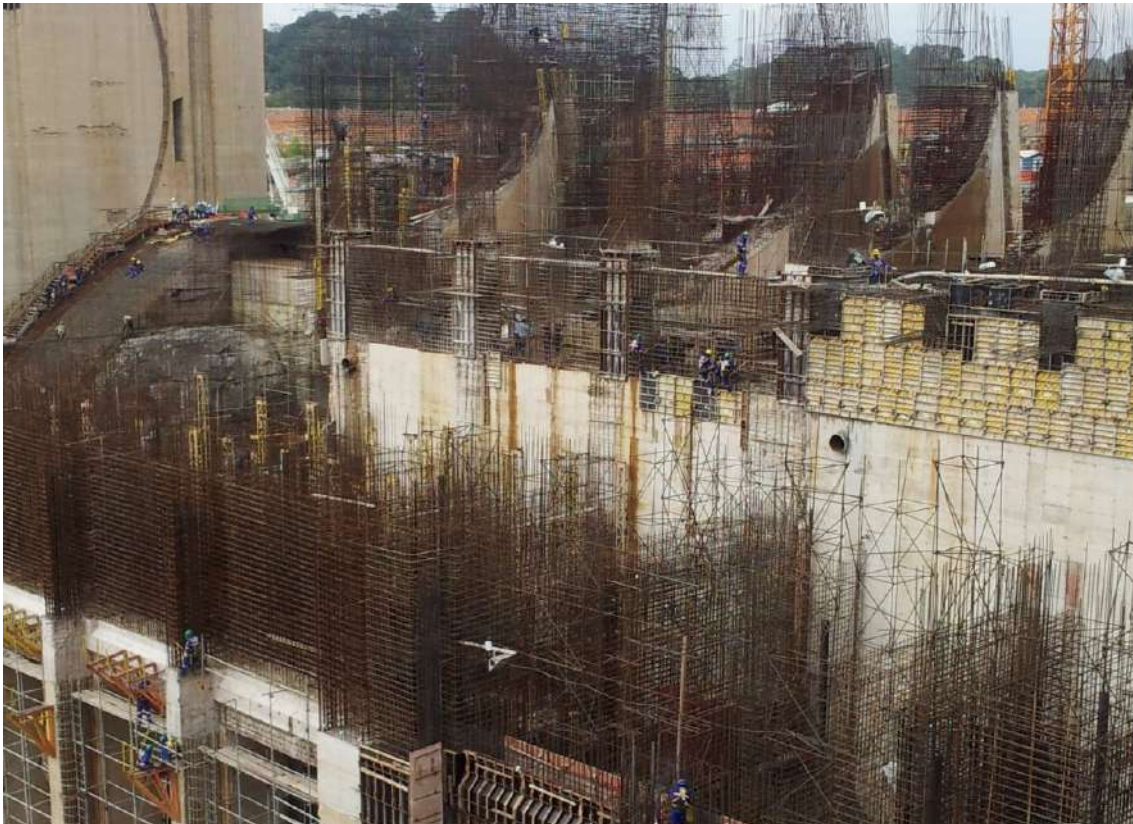
Imagem 288: Obra: Barragem Ferreira Gomes – Amapá
