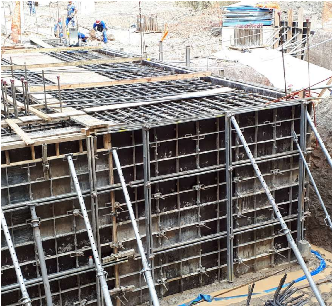
Imagem 220: Obra Birmann – São Paulo – Arremate de madeira
