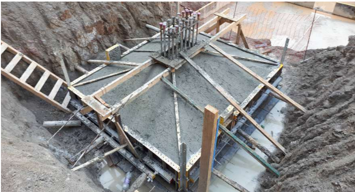
Imagem 228: Obra Edifício Birmann B32 - São Paulo - fôrma metálica para bloco de fundação
