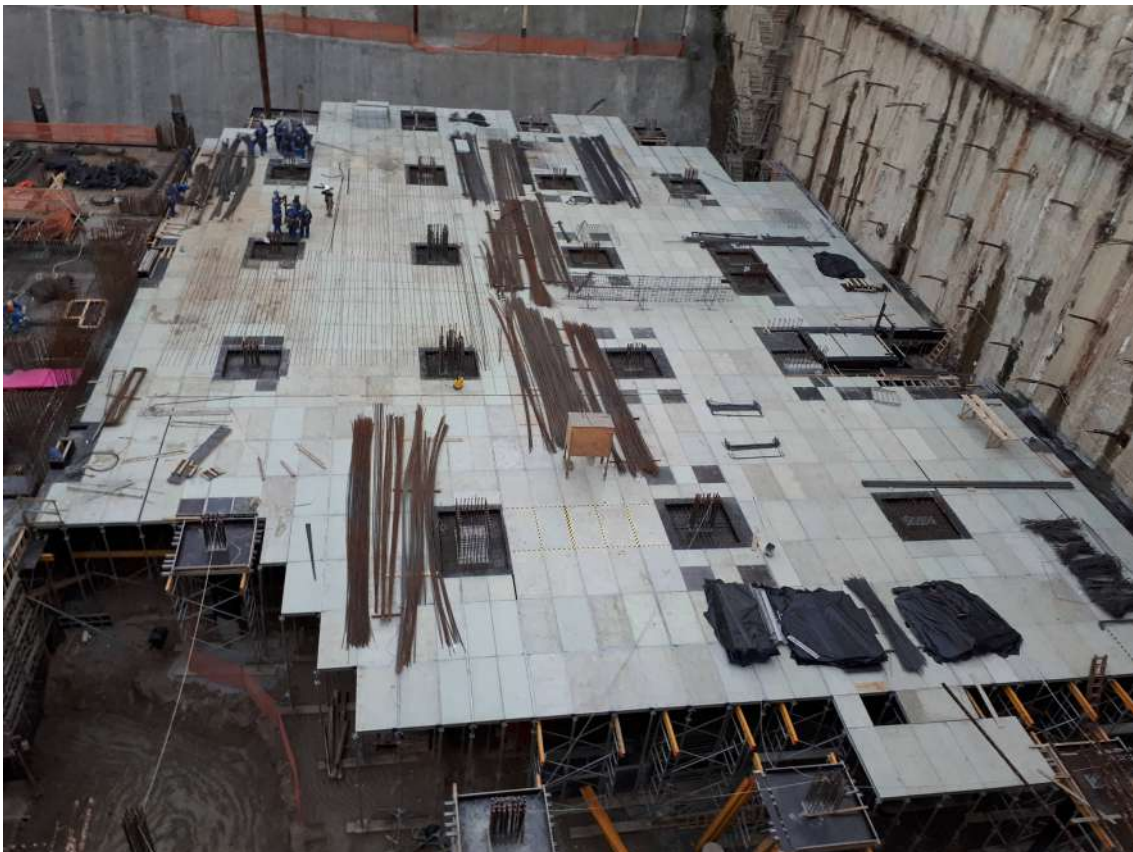
Imagem 128: Obra Edifício Birmann - São Paulo - fôrmas metálicas para lajes - Topec® SH
