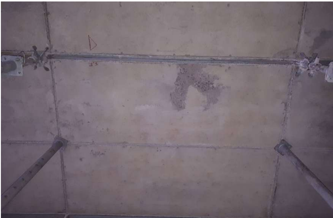
Imagem 33: Obra Edifício Birmann B32 - São Paulo
