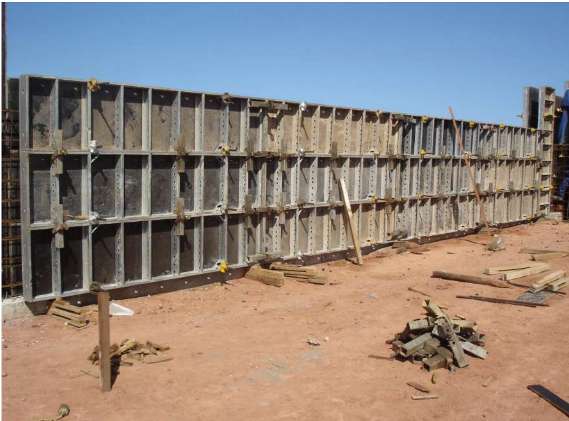
Imagem 147: Obra ETE Barra de Pojuca - Bahia
