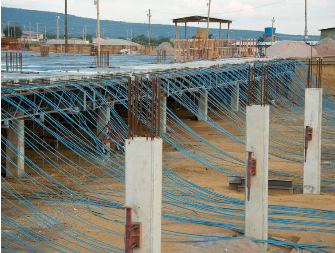
Imagem 68: Obra Boulevard Shopping Vitória da Conquista - Bahia
