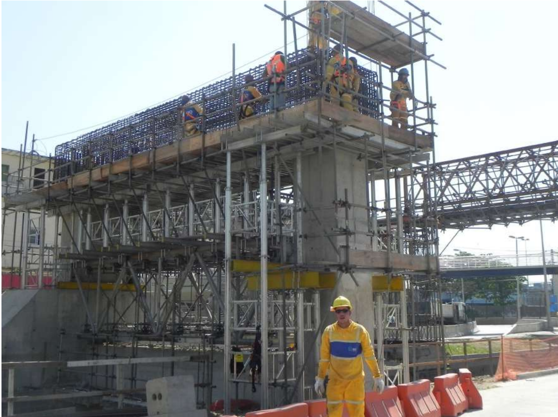
Imagem 307: Obra Passarela Avenida Brasil – Rio de Janeiro
