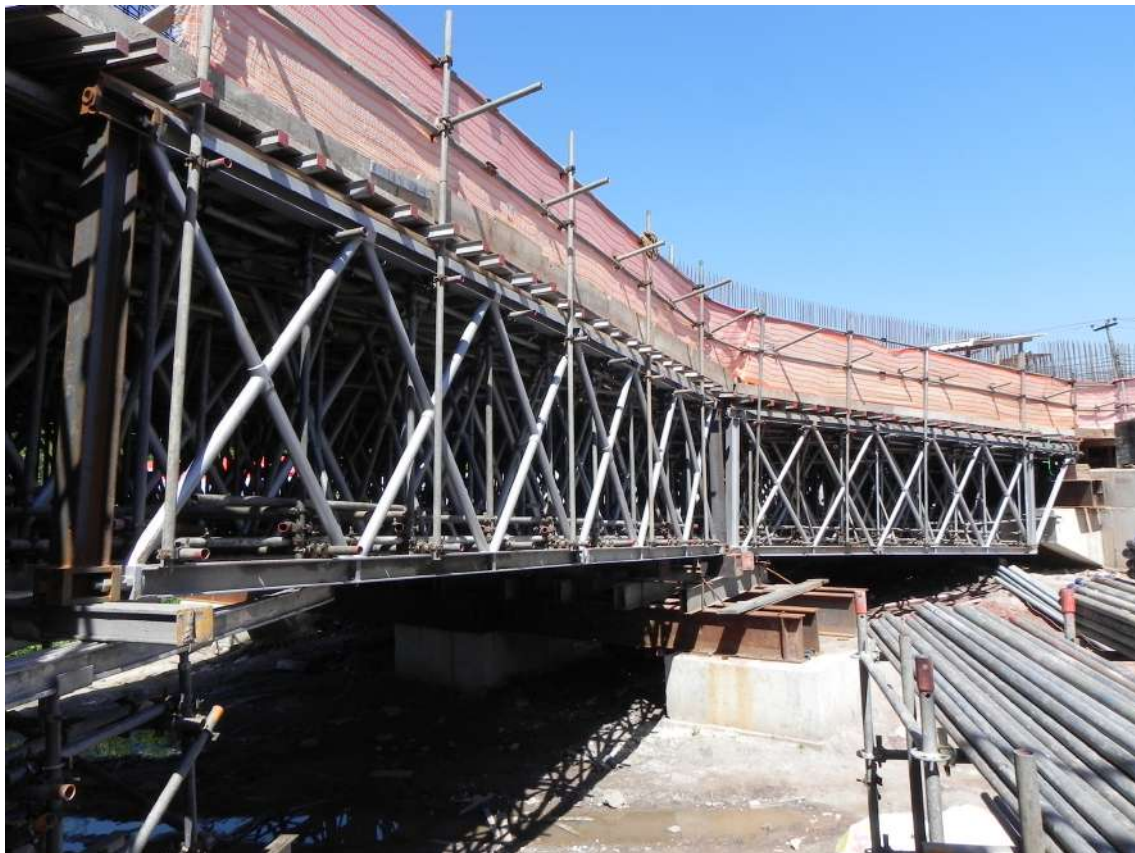
Imagem 299: Obra ponte estaiada Transcarioca - Rio de Janeiro - Treliza SH 300
