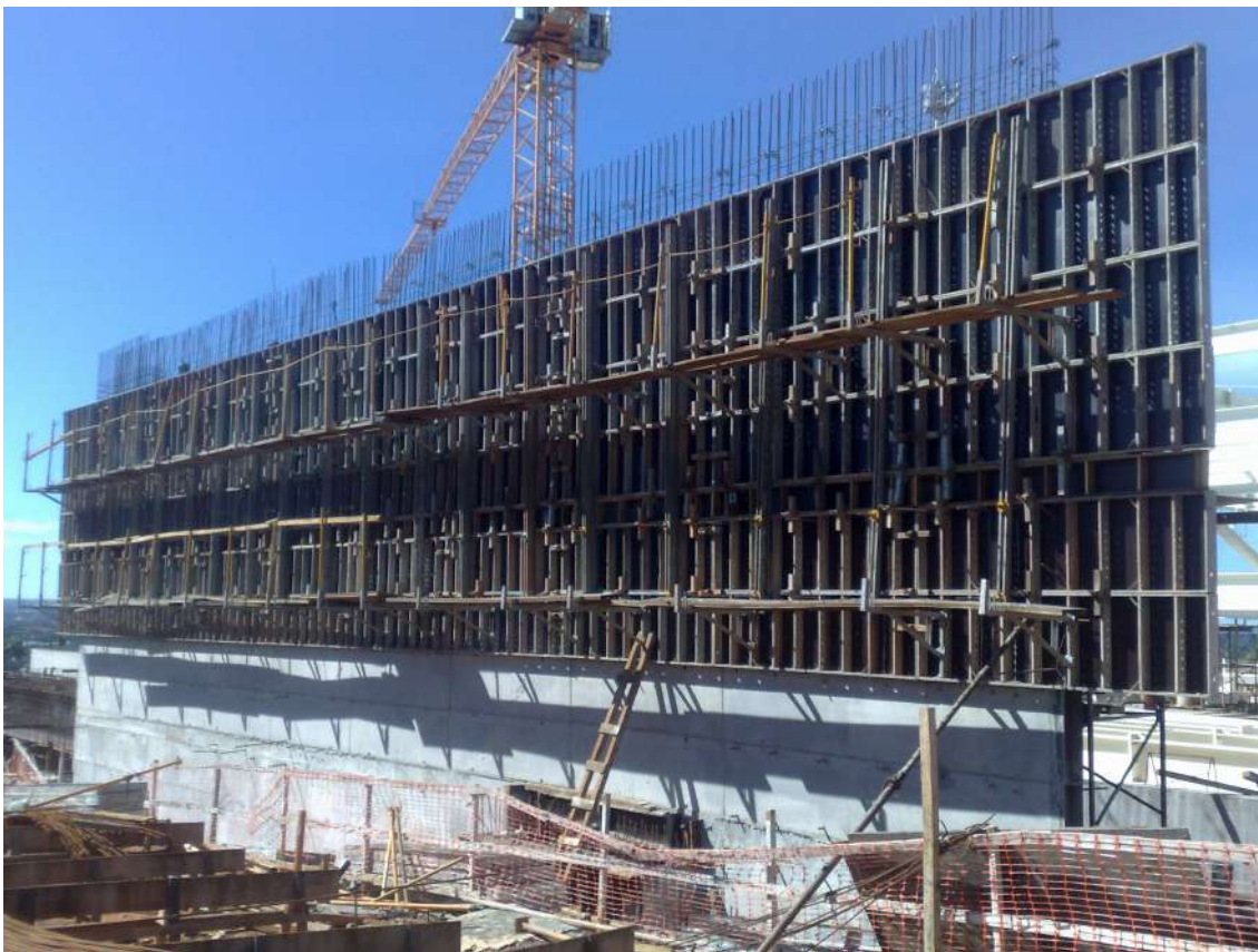
Imagem 223: Obra Edifício sede do SEBRAE Nacional – Distrito Federal
