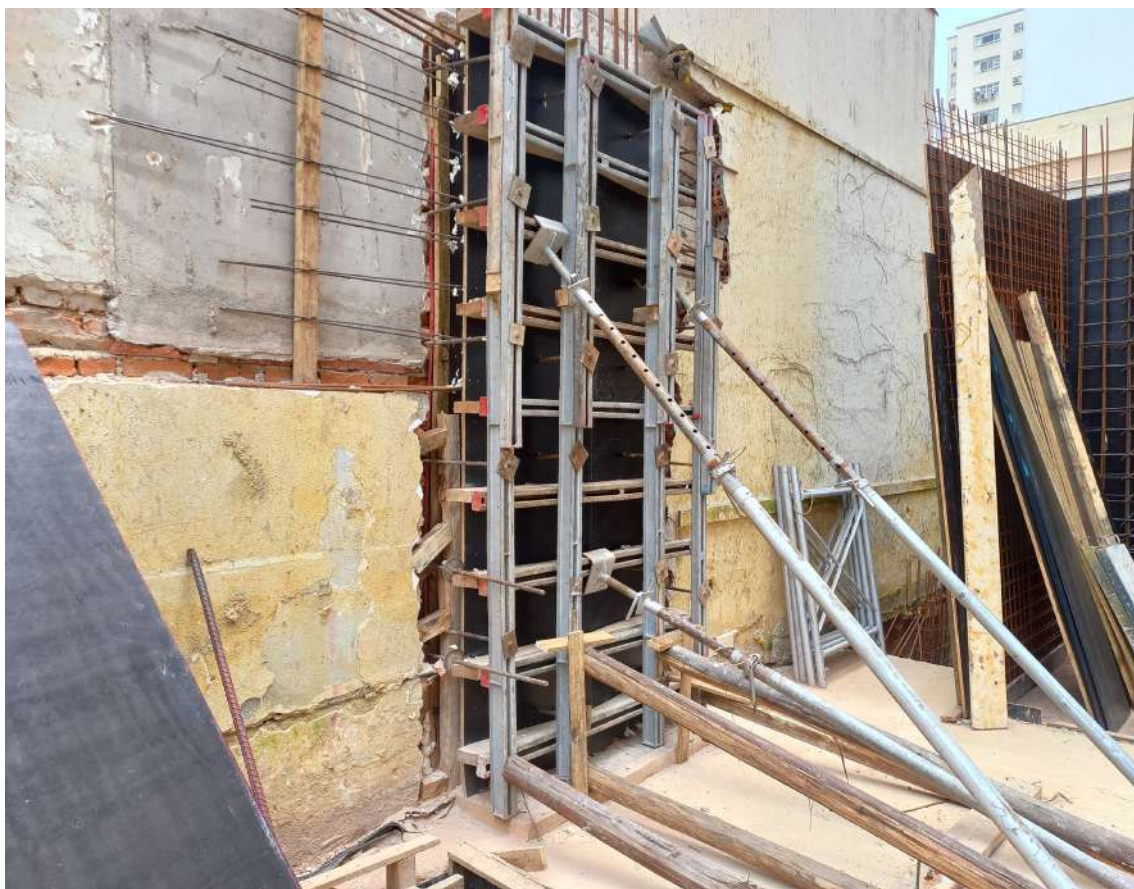
Imagem 208: Obra JK Square – São Paulo – Pilar dentro da parede
