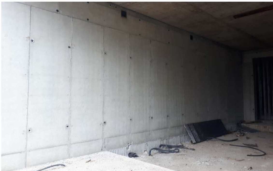
Imagem 215 – Obra Residência RJVD – São Paulo
