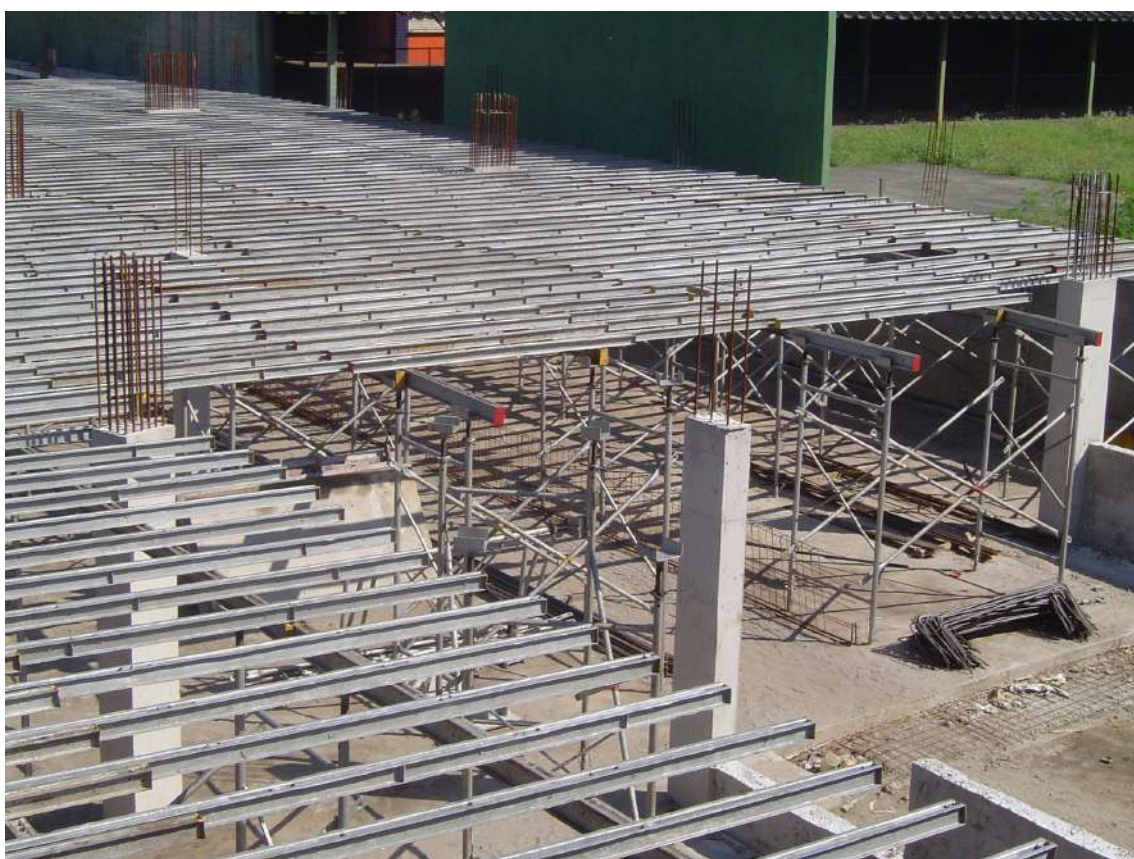
Imagem 61: Obra Edifício Global Tower - Espírito Santo
