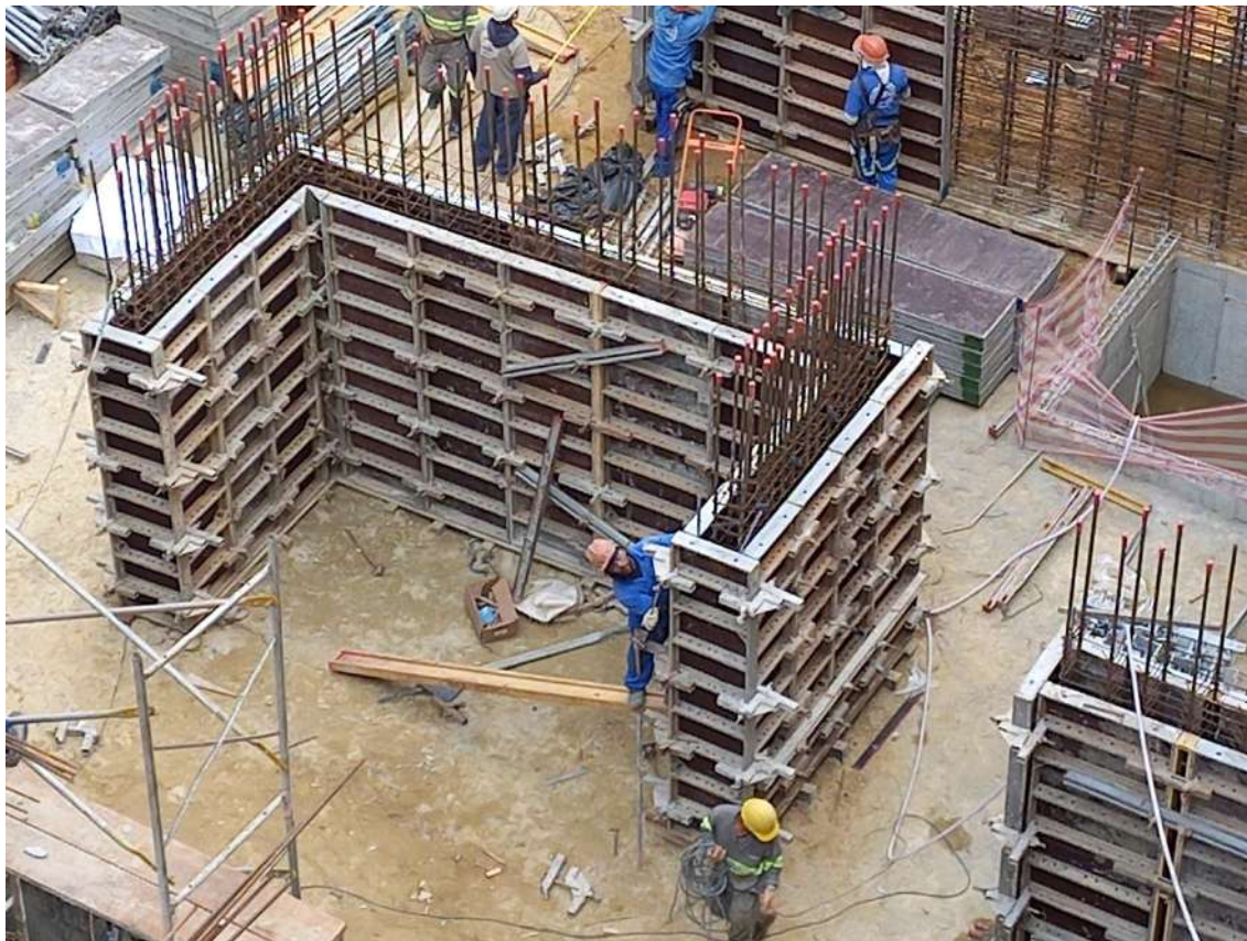
Imagem 209: Obra JK Square - São Paulo - pilar parede
