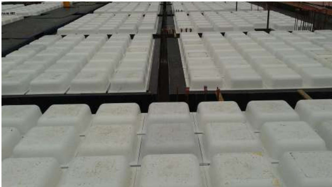
Imagem 65: Obra Edifício comercial Blue Chip - Santa Catarina
