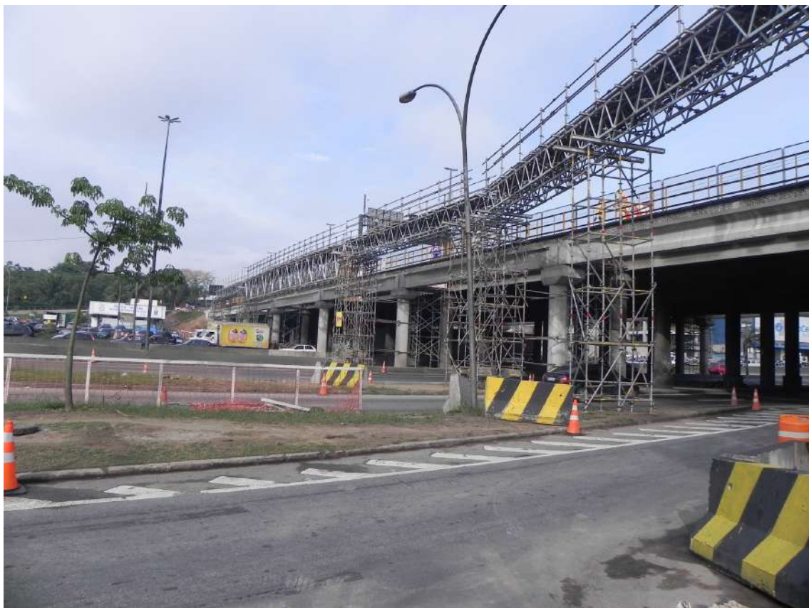
Imagem 296: Obra Ampliação de viaduto na Linha Amarela - Rio de Janeiro
