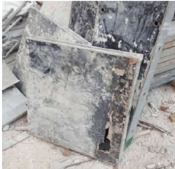
Imagem 31: Obra Edifício Birmann B32 - São Paulo
