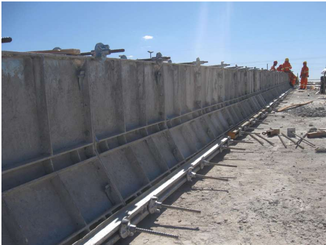
Imagem 311: Obra - BRT Sul – Distrito Federal
