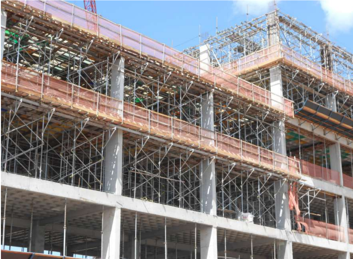
Imagem 108: Obra Hospital Abelardo Santos - Pará
