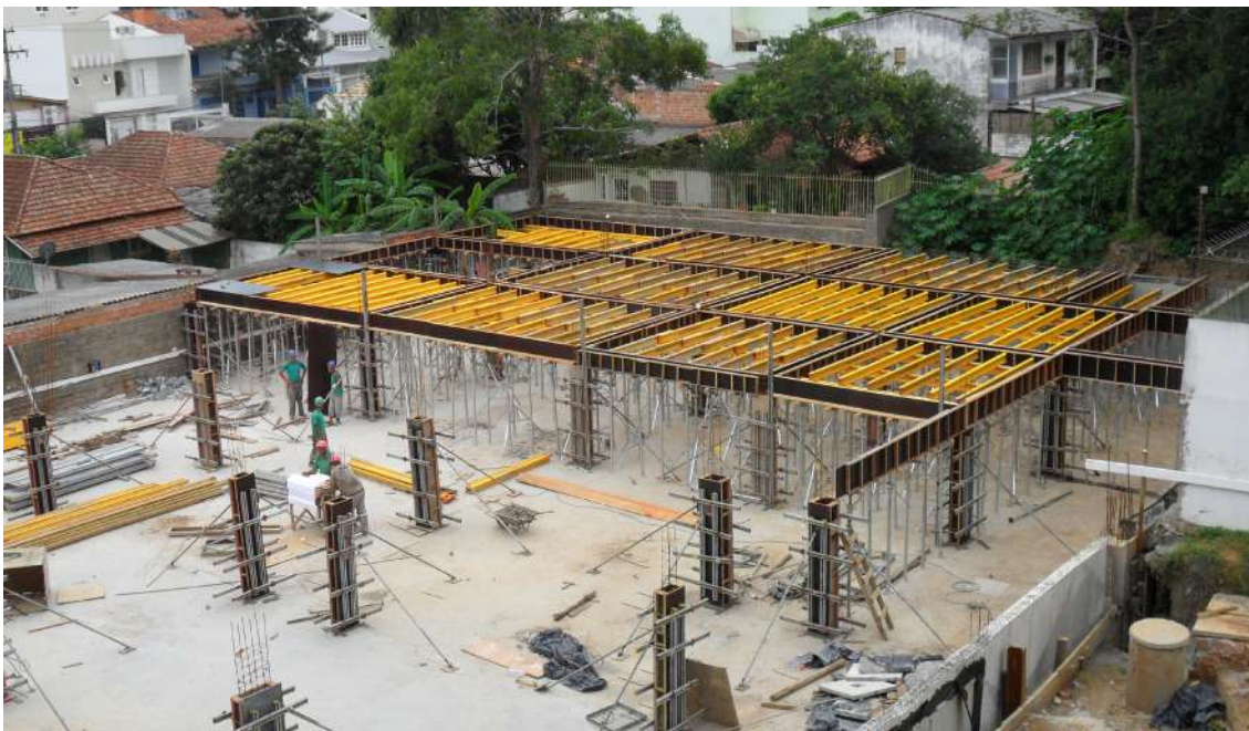
Imagem 180: Obra Edifício Serenitá – Rio Grande do Sul
