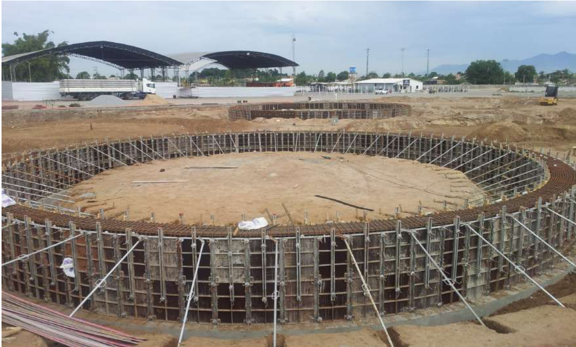
Imagem 279: Obra Cattalini SA - Paraná - base para tanques
