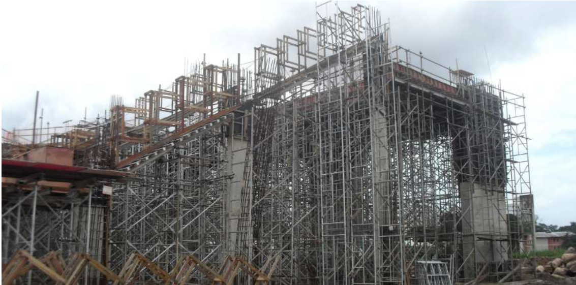
Imagem 71: Obra estádio olímpico do Pará (Mangueirão) - Pará
