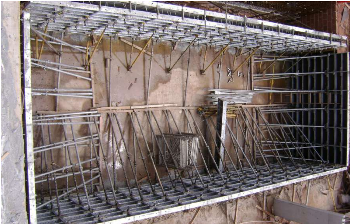
Imagem 159: Obra Residencial Laguna - Bahia
